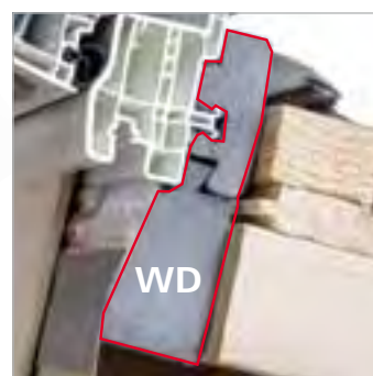
1. Bloque de aislamiento térmico* (WD) perimetral para reducir los puentes térmicos
